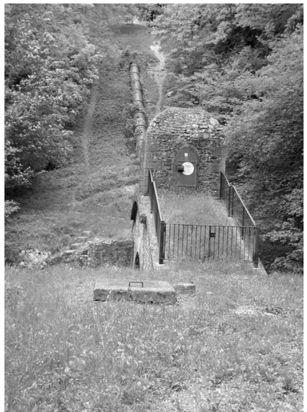
Photo 2. L'aqueduc de la Dhuis, siphon Chierry (cliché Eau de Paris).
