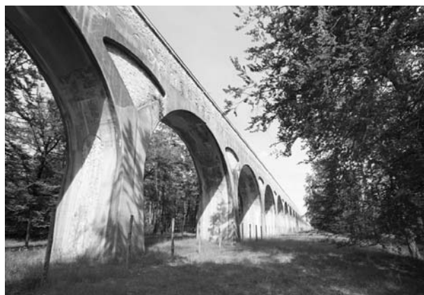
Photo 3. L'aqueduc de la Vanne (cliché Eau de Paris).
