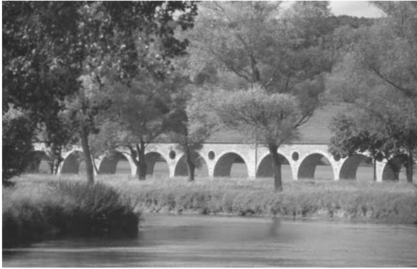
Photo 4. L'aqueduc de l'Avre (cliché Eau de Paris).
