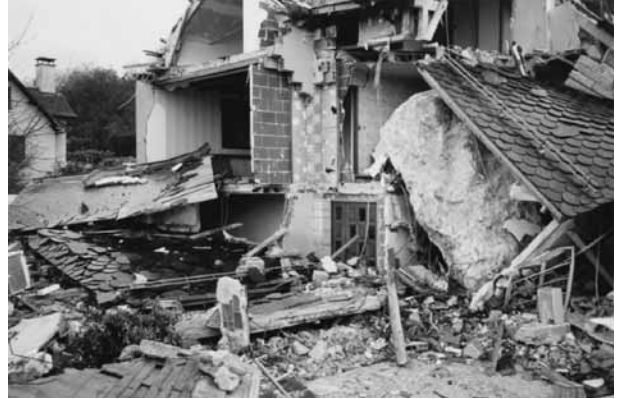
Photo 1. Chutes de blocs à Barjac (48) en 1995 (cliché CETE de Lyon).
