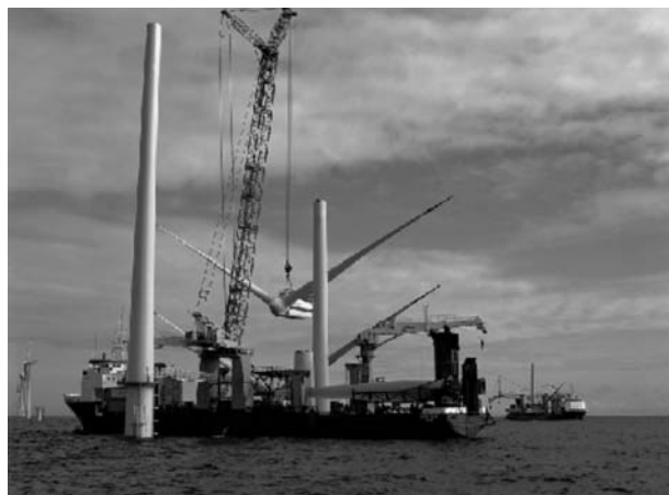
Photo 5. Les éoliennes de Horns Rev, Danemark, en construction (cliché Vestas).
