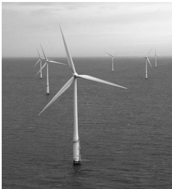
Photo 4. Les éoliennes de North Hoyle (cliché Vestas).
