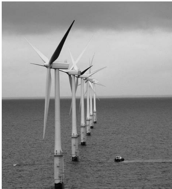
Photo 3. Les éoliennes de North Hoyle (cliché Vestas).
