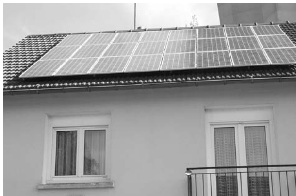
Photo 2. Exemple de site isolé : bâtiment à Nouan-les-Fontaines, 32 modules, 2400 w, 2400 ampères/h pour les batteries (cliché Forclum).
