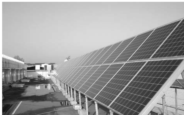
Photo 1. Exemple de site raccordé de particulier : 24 modules, 2160 wc (puissance-crête en watts correspondant à un ensoleillement optimum) (cliché Forclum).
