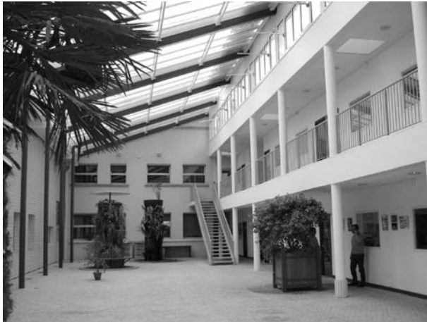
Photo 3. Exemple de bâtiment industriel, les bureaux de Forclum à Joué-les-Tours : 42 modules représentant une puissance de 3360 wc et 60 modules représentant une puissance de 10 200 wc en triphasé (cliché G. Sustrac).
