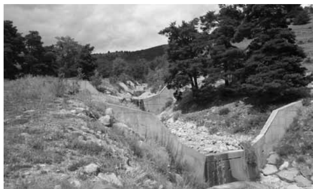
Photo 3. Exemple d'aménagement du Verdarel : blocs coincés par des dents freineuses (cliché SGMB).
