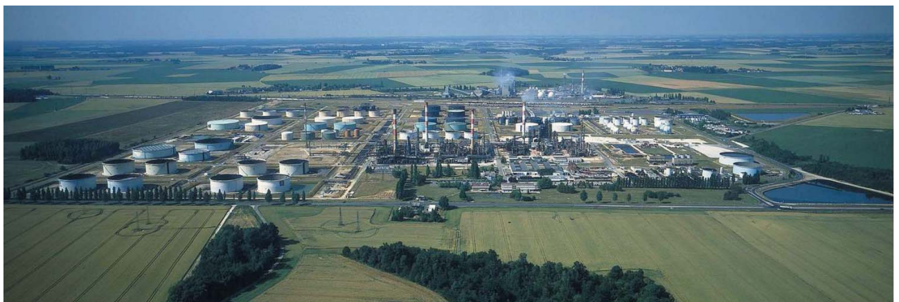
Photo 1. Vue générale de la raffinerie de Grandpuits (cliché Total Raffinerie de Grandpuits).
