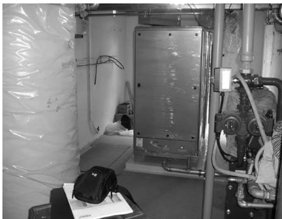
Photo 1. La pile à combustible installée à La Source (cliché EDF).
