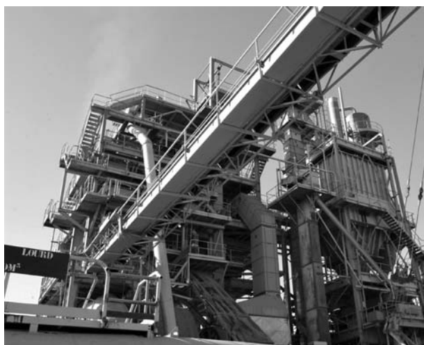
Photo 4. Usine de traitement du minerai d'Akouta. COMINAK, Niger (cliché AREVA/Jean-Marie Taillat).
