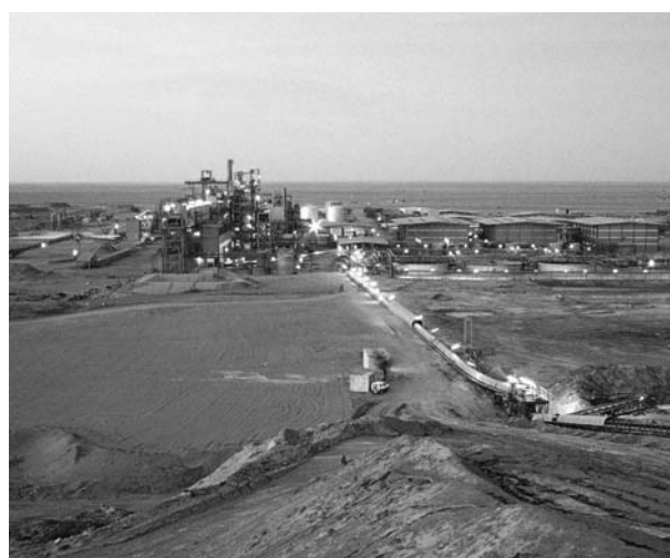
Photo 2. Usine de traitement du minerai de la SOMAÏR, Arlit, Niger (cliché AREVA/Olivier Martel).
