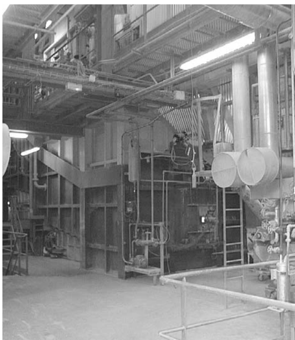
Photo 3. Les fours d'incinération (cliché Orvade).
