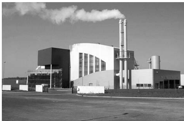
Photo 1. Vue générale de l'usine (cliché Orvade).
