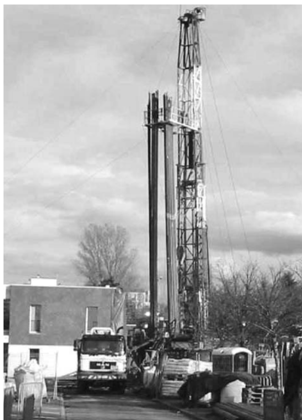
Photo 2. Le forage n°1 en cours (cliché CFG Services).
