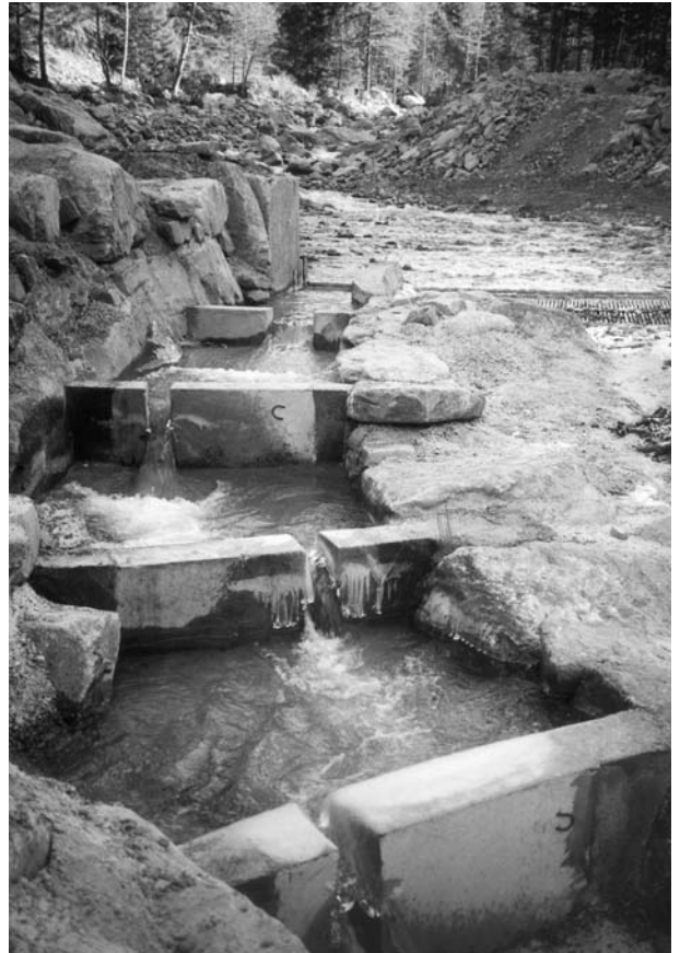
Photo 6. Exemple de passe à poisson : centrale de haute chute du martinet à Méolans-Revel, 04 (droits réservés).
