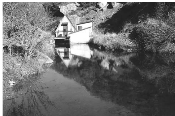
Photo 4. Prise d'eau de la centrale de haute chute du Litor à Arbéost, 65 (droits réservés).
