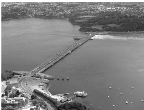
Photos 1 et 2. Vues aériennes de l'usine marémotrice de la Rance (clichés EDF Médiathèque G. Halary).
