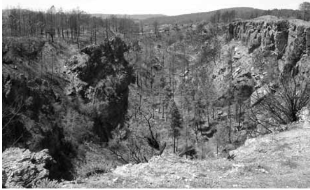
Photo 6. Vue générale du ciel ouvert de Covas (cliché Gérard Sustrac).
