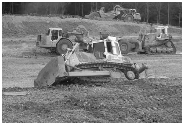
Photo 2. Scrapers au travail (cliché ARCOUR).
