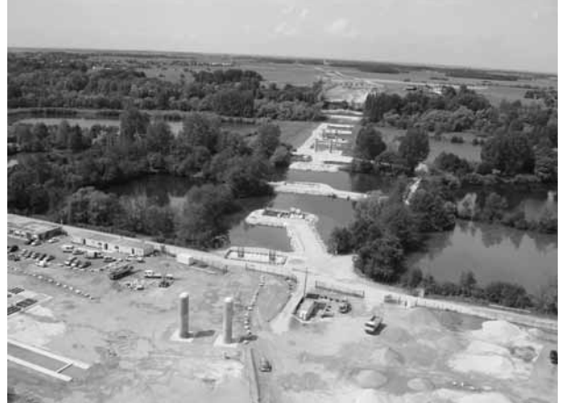
Photo 3. Vue aérienne du viaduc du Loing en construction (cliché ARCOUR).
