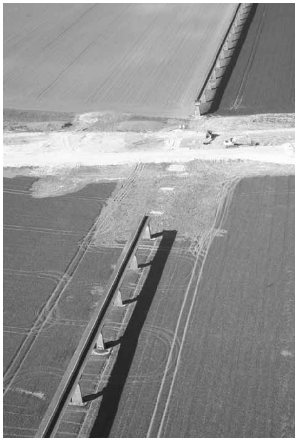
Photo 1. Le tracé de l'autoroute recoupe la rampe de l'aérotrain (cliché ARCOUR).
