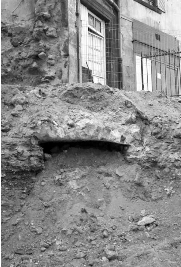
Figure 6. Cavité partiellement comblée à Clermont Ferrand (cliché CEBTP-SOLEN).
