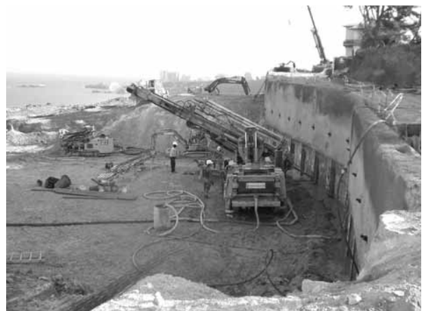
Photo 4. Exemple de mur ancré par tirants (cliché ANTEA).
