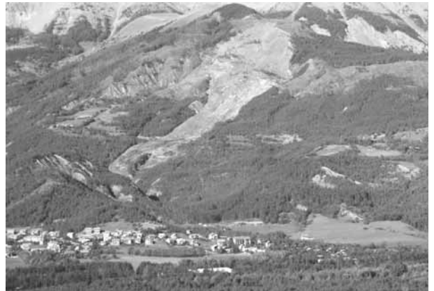
Photo 1. Vue générale du secteur de La Valette (cliché RTM).
