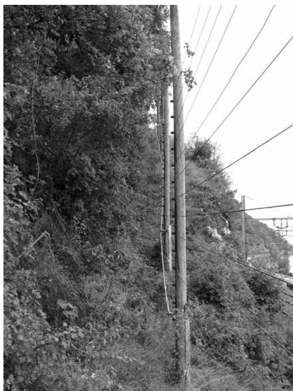
Photo 5. Filets détecteurs verticaux sur poteaux bois (cliché SNCF).
