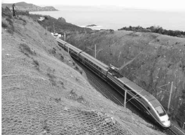
Photo 4. Exemple de tranchée confortée par grillage plaqué ancré (cliché SNCF).
