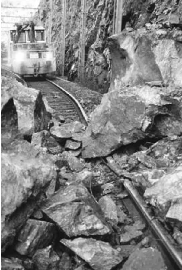
Photo 3. Éboulement dans une tranchée équipée de filets détecteurs (cliché SNCF).
