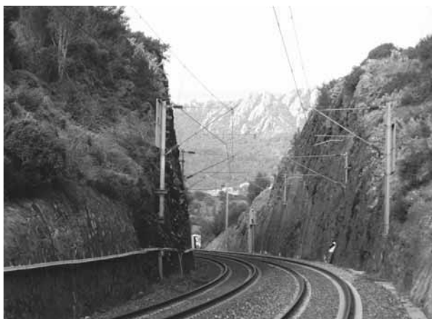
Photo 2. Exemple de tranchée rocheuse sur ligne classique (cliché SNCF).
