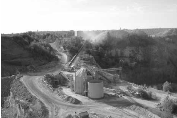
Photo 3. Vue des installations de concassage primaire et secondaire (cliché Gérard Sustrac).
