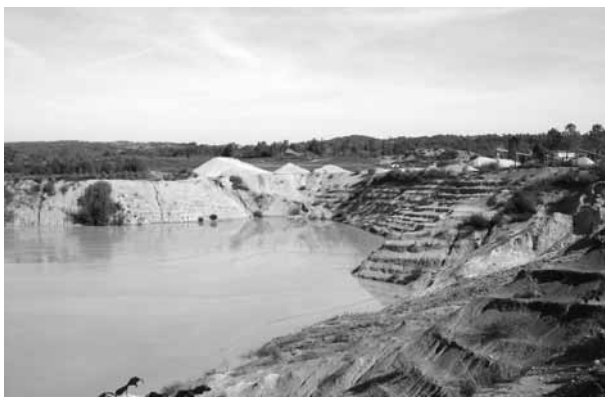
Photo 5. Le bassin de décantation des boues issues du traitement (cliché Gérard Sustrac).
