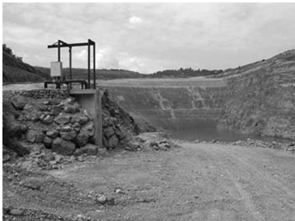
Photo 3. Installation de la pompe prévue initialement à la cote +10 m. Cette pompe ne sera pas utilisée.
