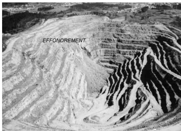
Photo 2. Effondrement du flanc de la carrière de Reocin (cliché AZSA).
