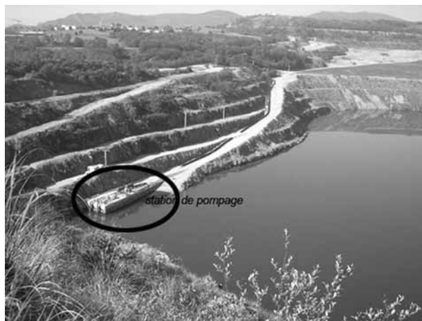
Photo 4. Installation actuelle de pompage (cote +13 m).
