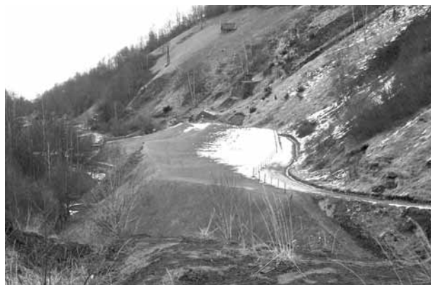
Photo 3. Vue générale du site de Sentein (cliché Mica Environnement).
