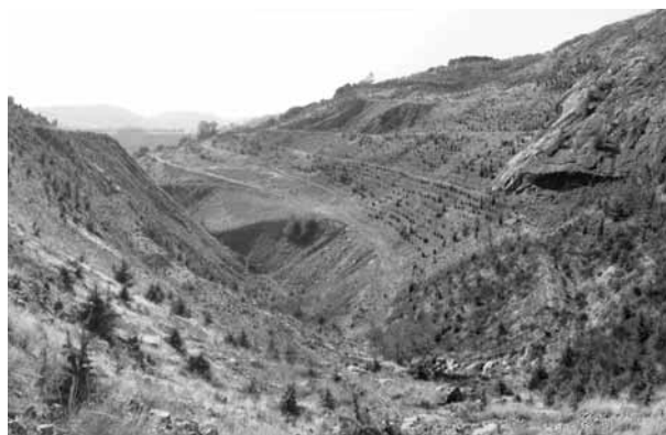
Photo 5. Vue générale du réaménagement du Bousquet d'Orb (cliché Mica Environnement).
