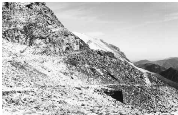
Photo 4. Retalutage après effondrement des chambres et piliers (cliché Mica Environnement).
