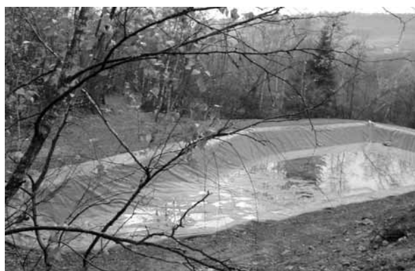
Photo 7. Bassin de rétention étanche (cliché Françoise Aye-Barthélémy, BRGM).
