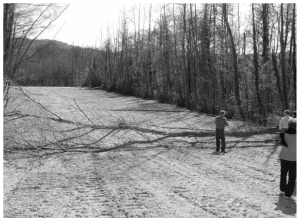
Photo 2. La zone des bassins après confinement et reprofilage. Avril 2004 (cliché Françoise Aye-Barthélémy, BRGM).
