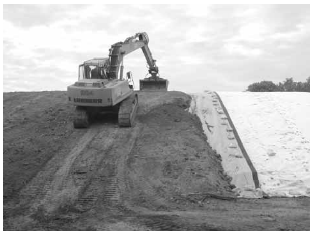
Photo 8. Mise en place de la couche de terre arable sur le stockage de pyrites grillées. De gauche à droite : terre végétale, géotextile drainant, géotextile de protection (cliché David Cazaux, BRGM).
